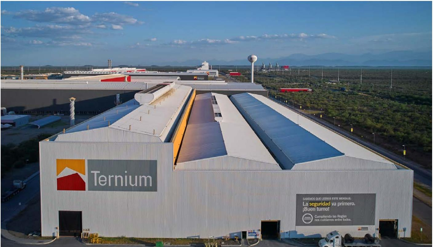
**Expansión del Centro Industrial de Pesquería, México.** Proyecto anunciado con tecnología DRI-EAF preparada para la captura de CO<sub>2</sub> y el uso de hidrógeno verde.
